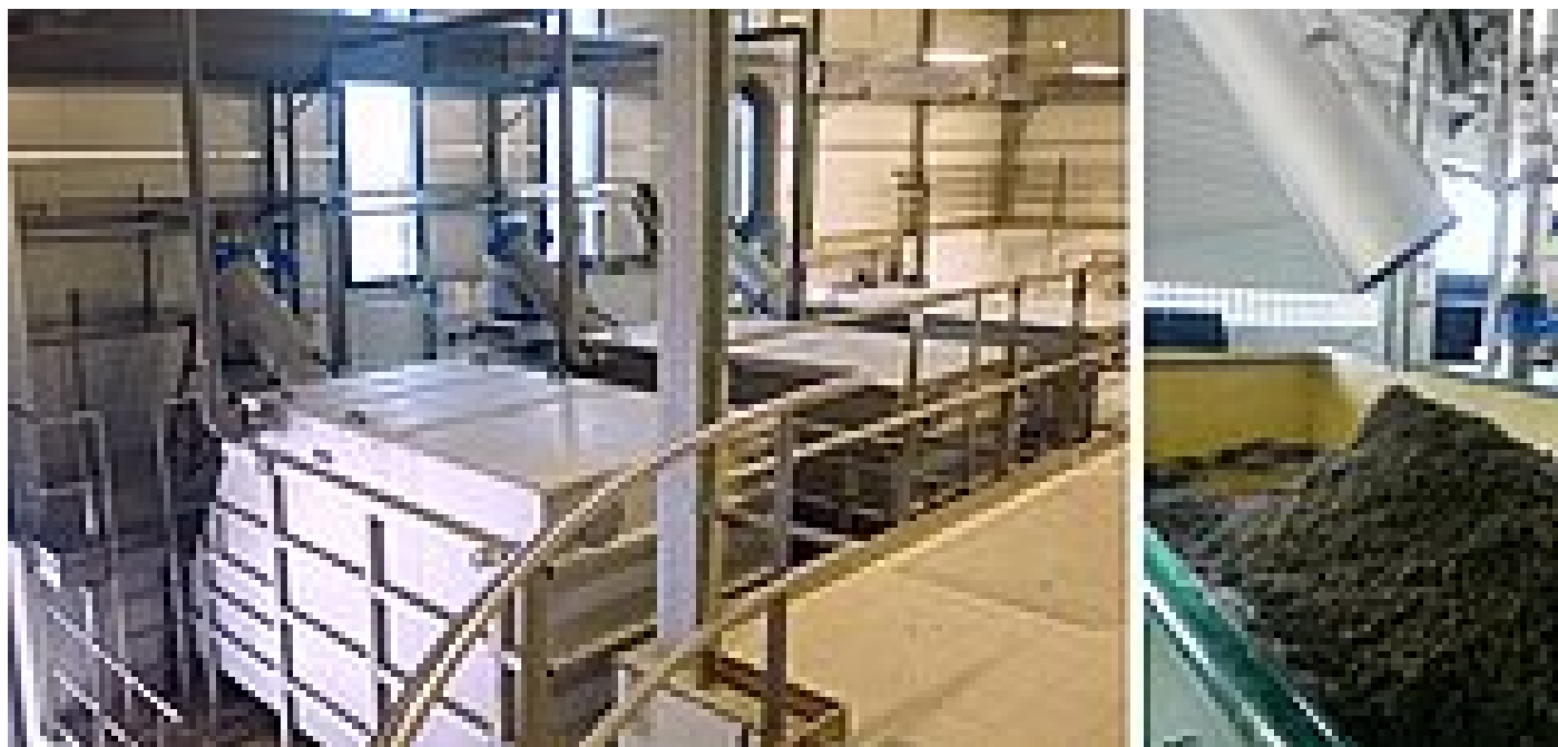
Image 1 : Installation de criblage fin HUBER ROTAMAT® STAR avec un débit de 1 000 m 3 /h et un résultat de déshydratation exceptionnel du criblage fin avec > 35 % RS
