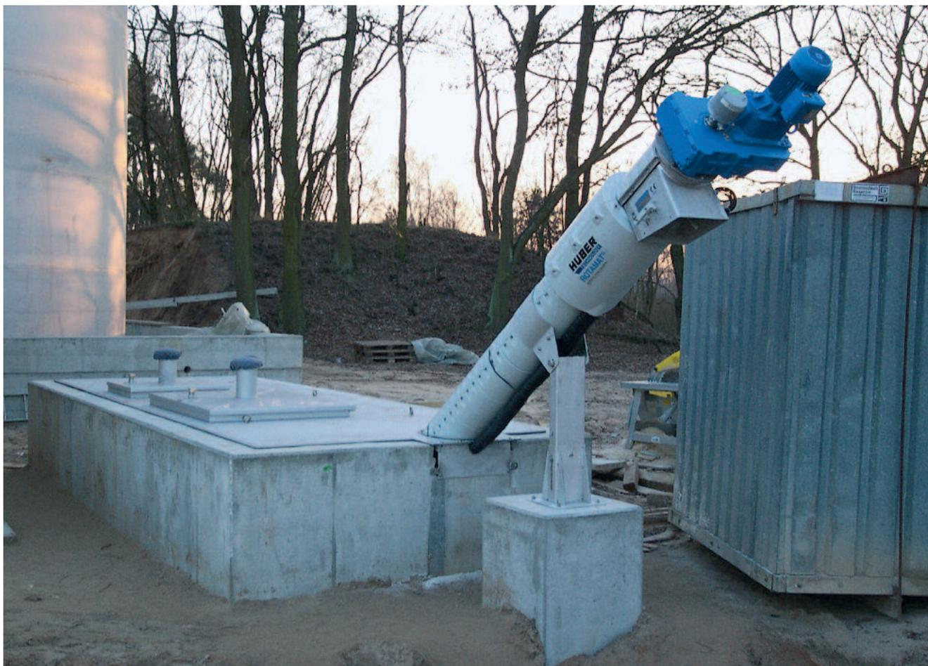
*Барабанная решетка HUBER ROTAMAT® Ro 2, установлена в усреднительной емкости.*
