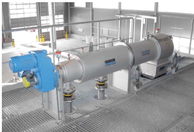
Le tamiseur de boues STRAINPRESS® de HUBER utilisé pour le dégrillage de digestat.
