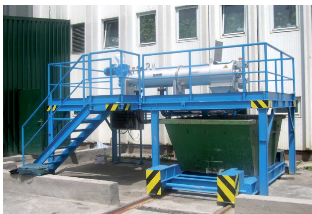
Installation extérieure d'un tamiseur de boues STRAINPRESS® 290 de HUBER.
