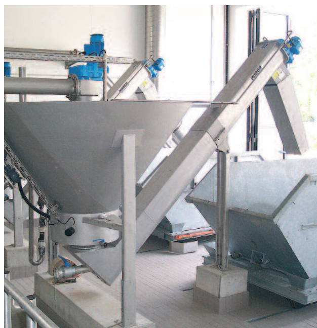
Réduction des coûts et amélioration de l'hygiène avec le laveur à sable RoSF4.
