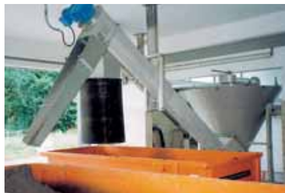
Une vis permet d'extraire les sables classifiés du fond du cône vers un container. La vis de classification est suspendue (palier bas) : la garantie d'un bon égouttage et d'une grande longévité.
