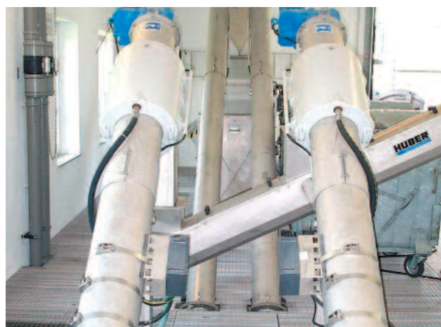
Installation de deux unités compactes Ro5 en sous-sol
