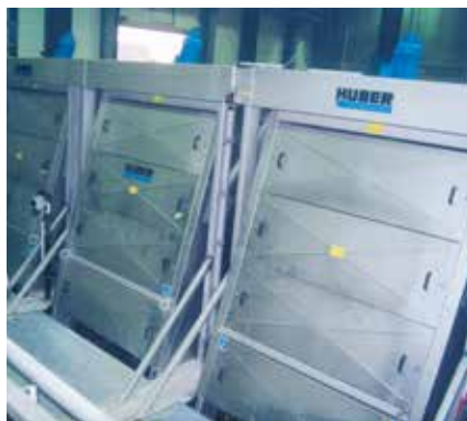
Dégrilleur fin à escalier HUBER STEP SCREEN® SSV - STEP SCREEN® amélioré.
