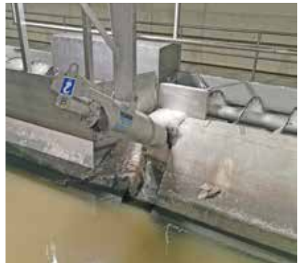
Dégrilleur eaux pluviales HUBER ROTAMAT® RoK1 TS
