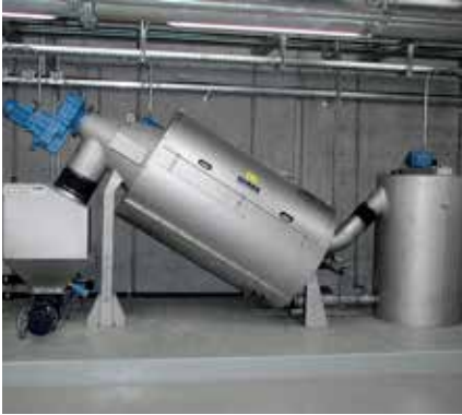
Extrêmement robuste: Épaisseur rotatif à vis HUBER S-DRUM.
