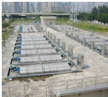
24 unités HUBER Disc Filter RoDisc® installées.
