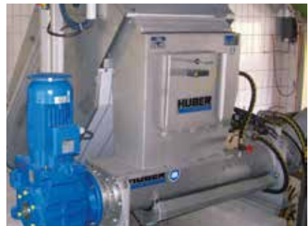
Presse-laveuse HUBER WAP® installé derrière un tamis fins à escalier HUBER STEP SCREEN®.
