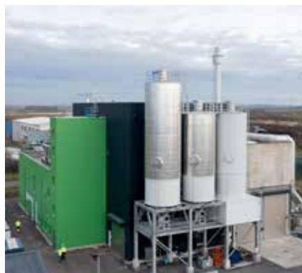
Usine de mono-incinération des boues d'épuration de Halle-Lochau.
