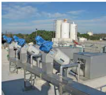
Tamis rotatif HUBER ROTAMAT® STAR protégeant les systèmes de filtration à membrane en aval.
