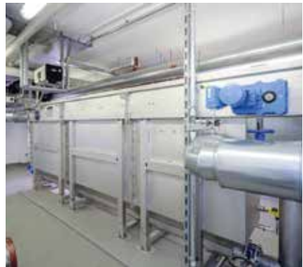
Échangeur de chaleur RoWin pour la récupération d'énergie.
