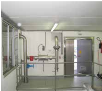
Système complet de ventilation forcée active HUBER.
