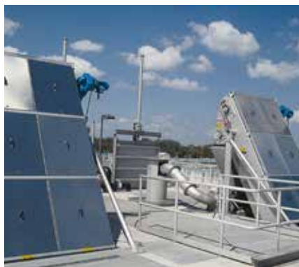
HUBER Tamis à champs filtrant EscaMax® - polyvalent tamis à haut rendement de séparation.
