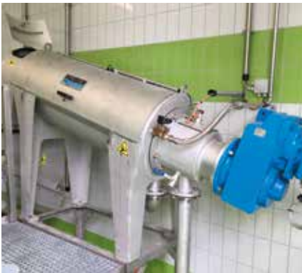
Presse à vis HUBER Q-PRESS® pour la déshydratation des boues excédentaires dans l'industrie des eaux minérales / boissons mixtes.
