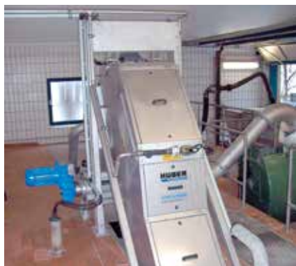
Dégrilleur fin à escalier HUBER STEP SCREEN® SSF - STEP SCREEN® d'origine.
