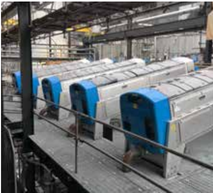
Déshydratation des boues avec la presse à vis HUBER Q-PRESS® 800.2.
