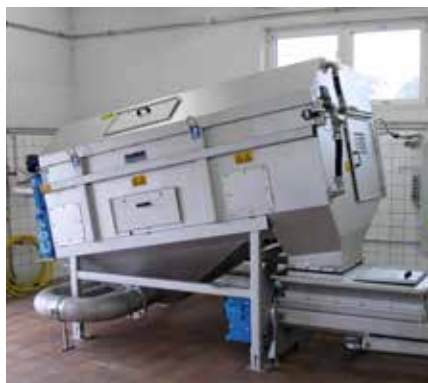
Dégrilleur de matières de vidanges fécales– Dégrilleur de matières de vidanges HUBER RoFAS.
