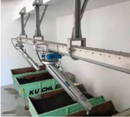
Solutions HUBER sur mesure pour le traitement des boues déshydratées.
