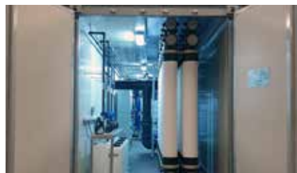
Phase de prétraitement par ultrafiltration pour l'élimination des suspensions.
