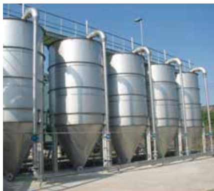
Filtre à sable HUBER CONTIFLOW®, modèle en acier inoxydable.
