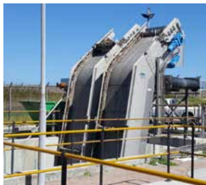
Tamis robuste pour l'enlèvement de particules grossières : Dégrilleur droit grossier TrashMax® HUBER.
