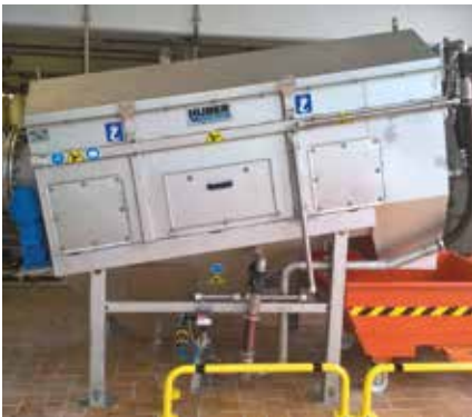
Lavage des gravillons contaminés avec le tambour de lavage polyvalent HUBER RoSF9.
