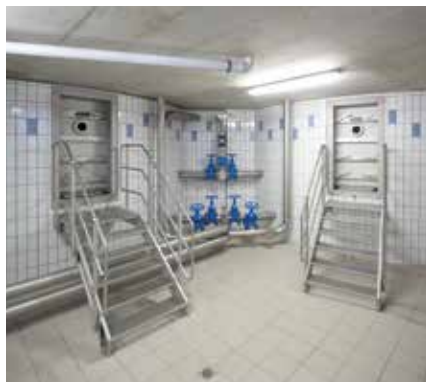
Portes HUBER étanches à la pression pour un accès sécurisé aux réservoirs.
