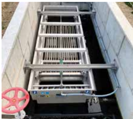
Échangeur de chaleur HUBER RoWin C installé dans un canal en béton.
