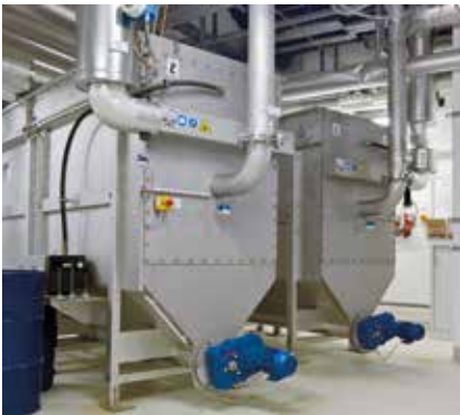
Échangeur de chaleur HUBER RoWin pour la récupération d'énergie.
