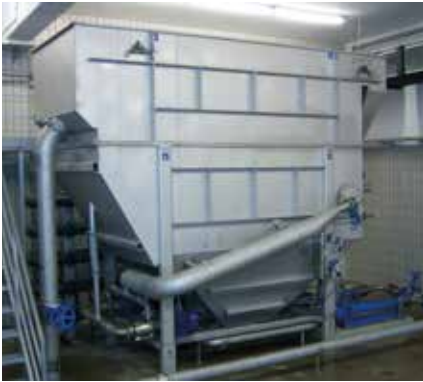
Installation de flottation à air dissous HUBER HDF pour la séparation des solides dans l'industrie des boissons.
