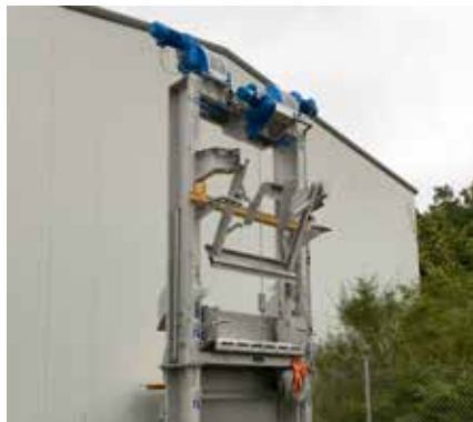
Dégrilleur à bols preneurs HUBER TrashLift pour l'élimination des matériaux grossiers.
