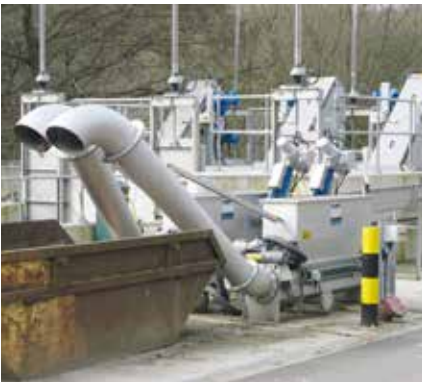
Presse-laveuse HUBER WAP® L avec collecteur. Système d'alimentation à canal : fonctionnement redondant et tamisage optimal pour la déshydratation.
