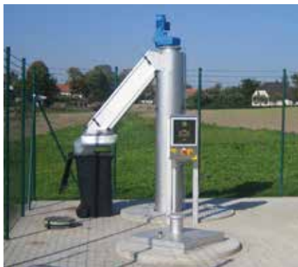
Stations de pompage HUBER Tamis RoK4 avec chauffage pour installation en extérieur.
