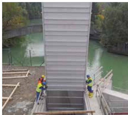
Tamisage des eaux de rivière avec le dégrilleur droit à raclage continu HUBER RakeMax® V pour les volumes élevés d'eaux usées.
