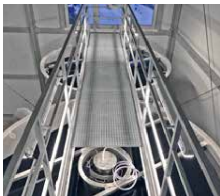
Filtre à charbon actif HUBER CONTIFLOW® GAK, conception en acier inoxydable, pour l'élimination des traces de substances.
