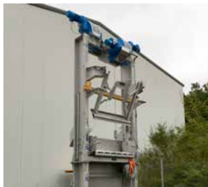
Le dégrilleur HUBER TrashLift pour l'enlèvement fiable de gros matériaux grossiers.
