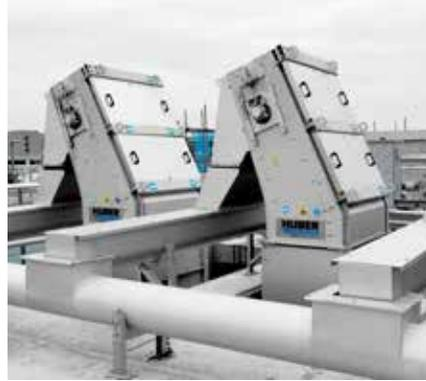
*RakeMax® CF combina las ventajas de una superficie de tamizado libre máxima con una eficiencia de separación muy alta. Además, ahorra espacio y reduce los costes de obras civiles.*
