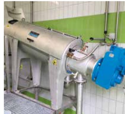
Prensa de tornillo HUBER Q-PRESS® para la deshidratación de excesos de lodos en la industria de agua mineral y bebidas combinadas.
