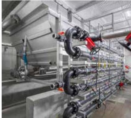
Planta de flotación de aire disuelto para un tratamiento fiable de aguas residuales.
