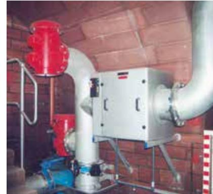
*Planta de filtro de aire HUBER para agua potable limpia.*
