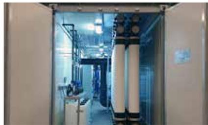
Fase de pretratamiento utilizando ultrafiltración para la extracción de suspensiones.
