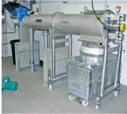
*Limpiador de lodos HUBER STRAINPRESS®: separación continua de material grueso a presión.*
