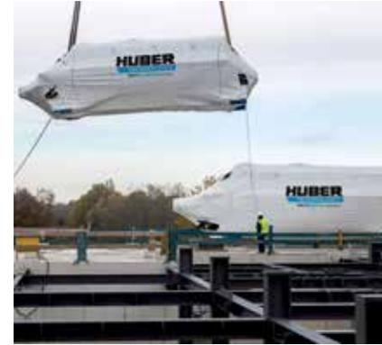
Un secador de disco HUBER RotaDry® durante la instalación in situ.
