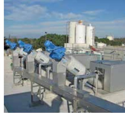
Tamiz para chapa perforada HUBER ROTAMAT® STAR que protege sistemas de filtración de membrana posteriores.
