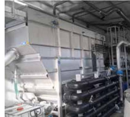
*Planta de flotación de aire disuelto HDF HUBER para la reducción de grasas y sólidos antes de la descarga indirecta.*
