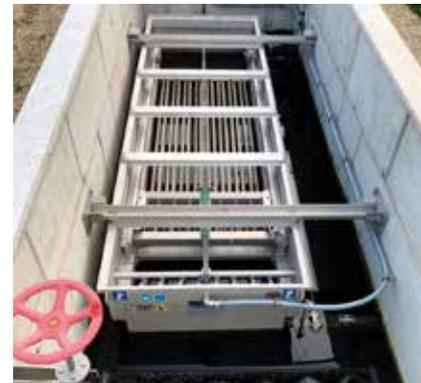
Intercambiador de calor HUBER RoWin C instalado en un canal de hormigón.
