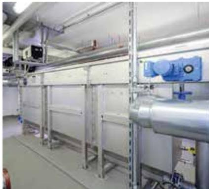
Intercambiador de calor RoWin para recuperación de energía.
