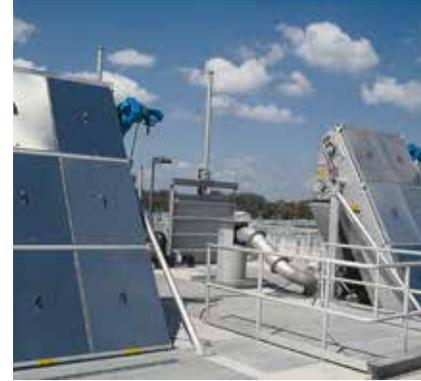
*Tamiz de cinta HUBER EscaMax®: versátil tamizado de visualización frontal con alta eficiencia de separación.*
