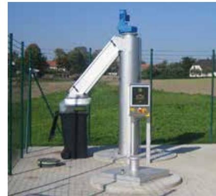
*Tamiz para pozos de bombeo HUBER ROTAMAT® RoK4 con calefacción para instalación en exteriores.*
