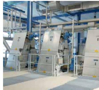
Reja de gruesos HUBER RakeMax®: diseño robusto para un funcionamiento fiable.
