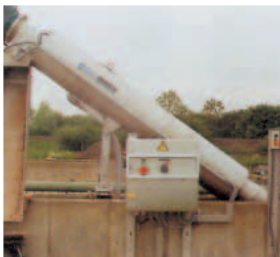
Unité ROTAMAT® Ro 9 dans sa version chauffée et calorifugée pour une installation en extérieur jusqu'à -25°C
