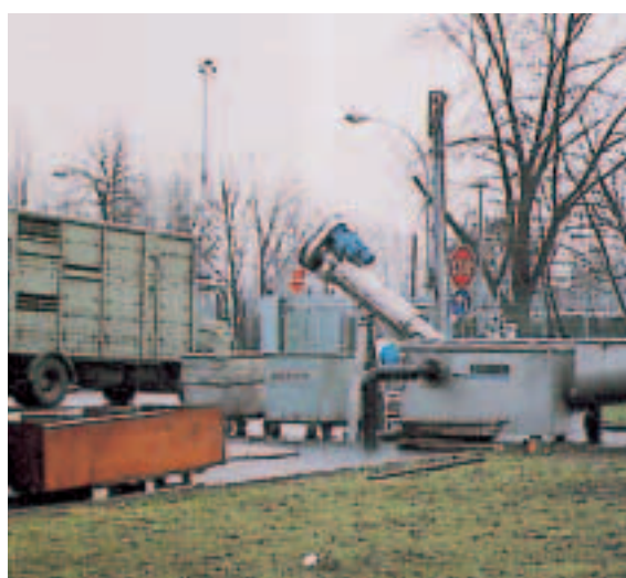
Unité ROTAMAT® Ro 9 installée en caisson inox pour le traitement des eaux de lavage de bétailière
